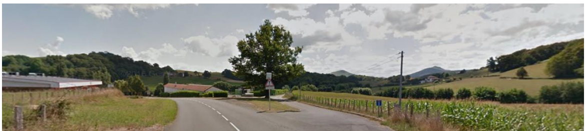
Fig. 1. Photo de l'accès existant
